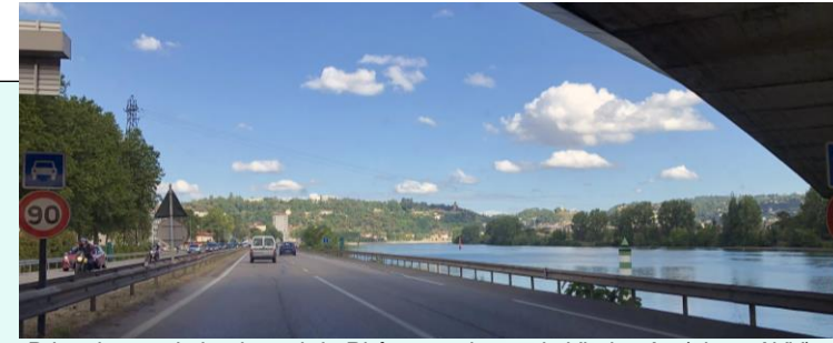
Prise de vue du boulevard du Rhône au niveau du Viaduc A7 (photo AVV)
