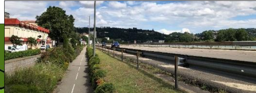
Prise de vue au niveau du centre commercial d'Estrassin (AVV)
