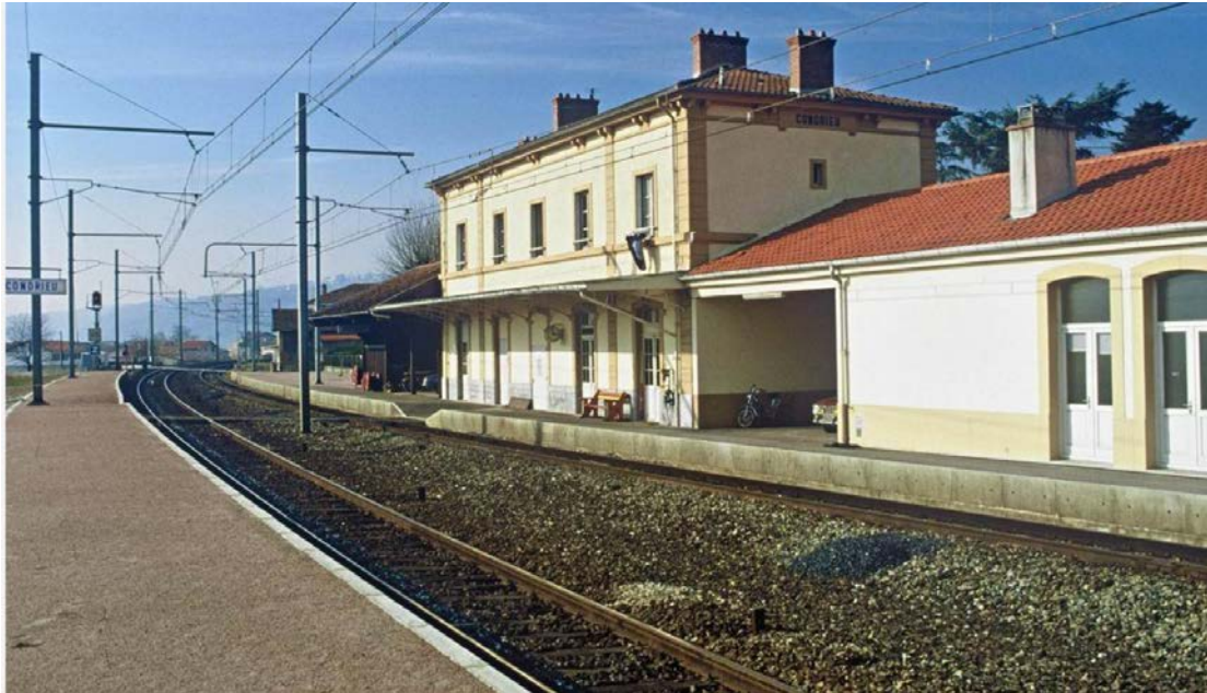
Figure 40 : Ancienne gare de Condrieu (source : archives SNCF)
